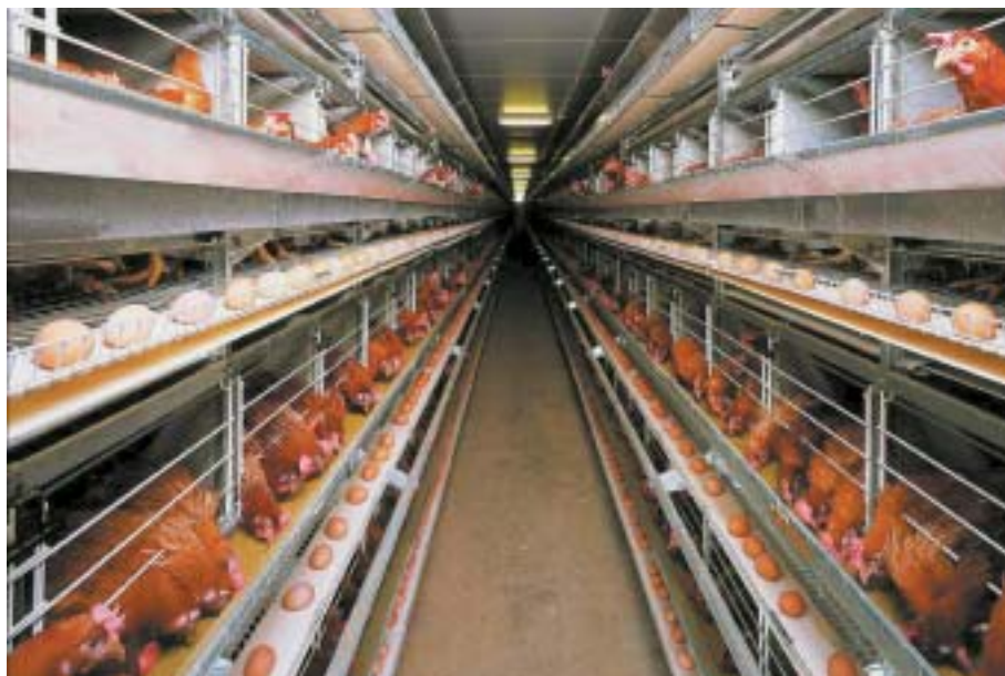
Stallanlagen, ausgerüstet mit Big-Dutchman-Technik
